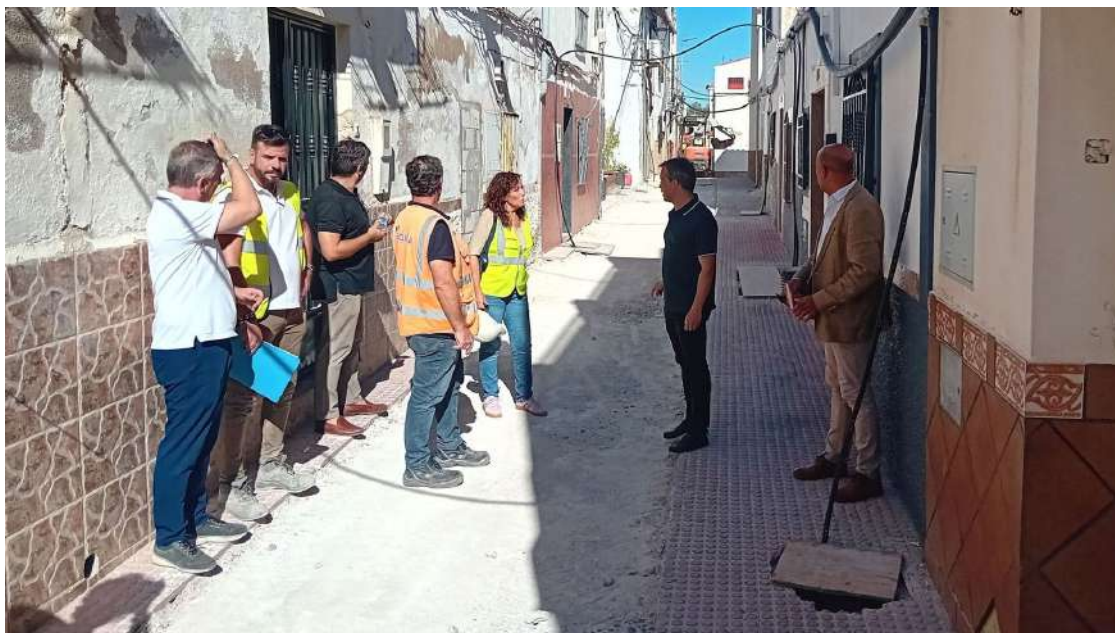
Visita a las obras de la calle Hospitalico. / M. Ibáñez
