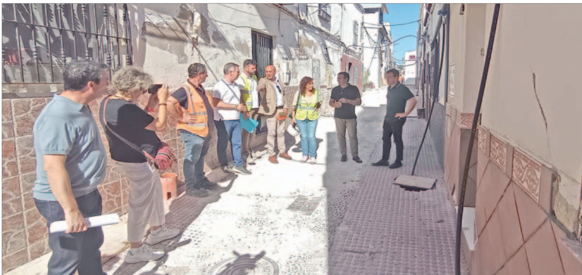
VISITA El alcalde, en su visita a la obra junto al edil de Mantenimiento Urbano, el concejal de Patrimonio, técnicos municipales y de la empresa Aqualia.
