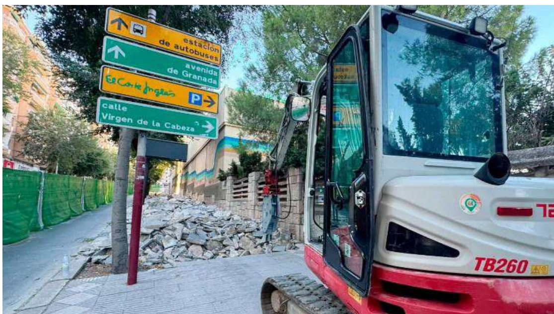
Obras en Avenida de Madrid. / Ayuntamiento de Jaén.
